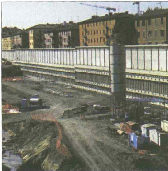
Il cantiere del nodo ferroviario dell'alta capacità a Bologna
